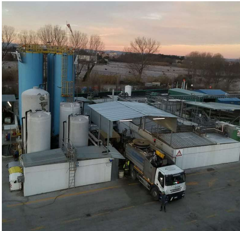
Figura 1 – Impianto vista aerea
